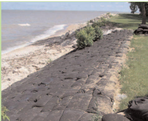
Shoreline Envirolok mattress wall
